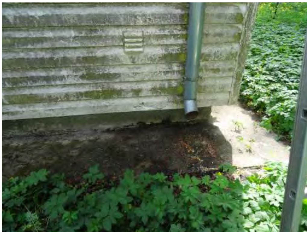
6.skatu punkts (ESOŠS COKOLAS, ĒKAS BETONA APMĀLE DIENVIDRIETUMU PUSĒ)
