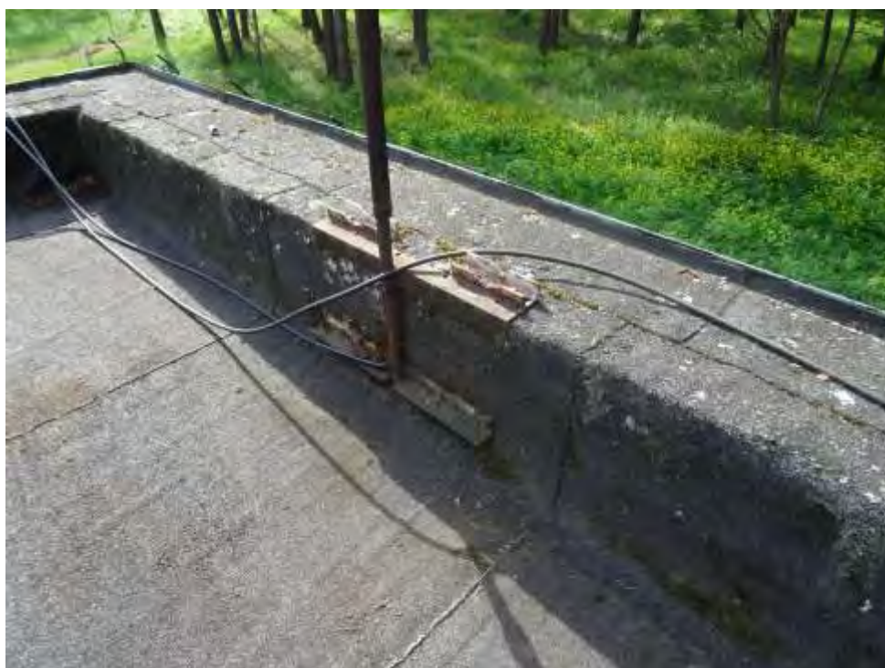
14.skatu punkts (ESOŠS ANTENAS STIPRINĀJUMS UZ JUMTA)
