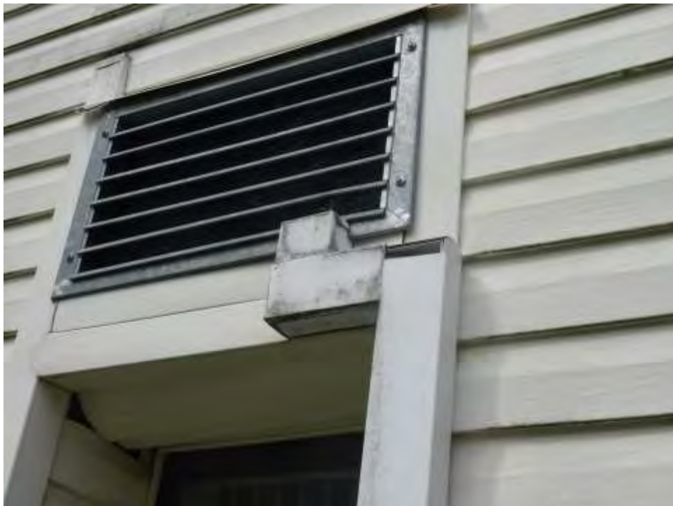
9.skatu punkts (AUSTRUMU FASĀDE VIRS LOGA VENTILĀCIJAS ŠAHTAS)
