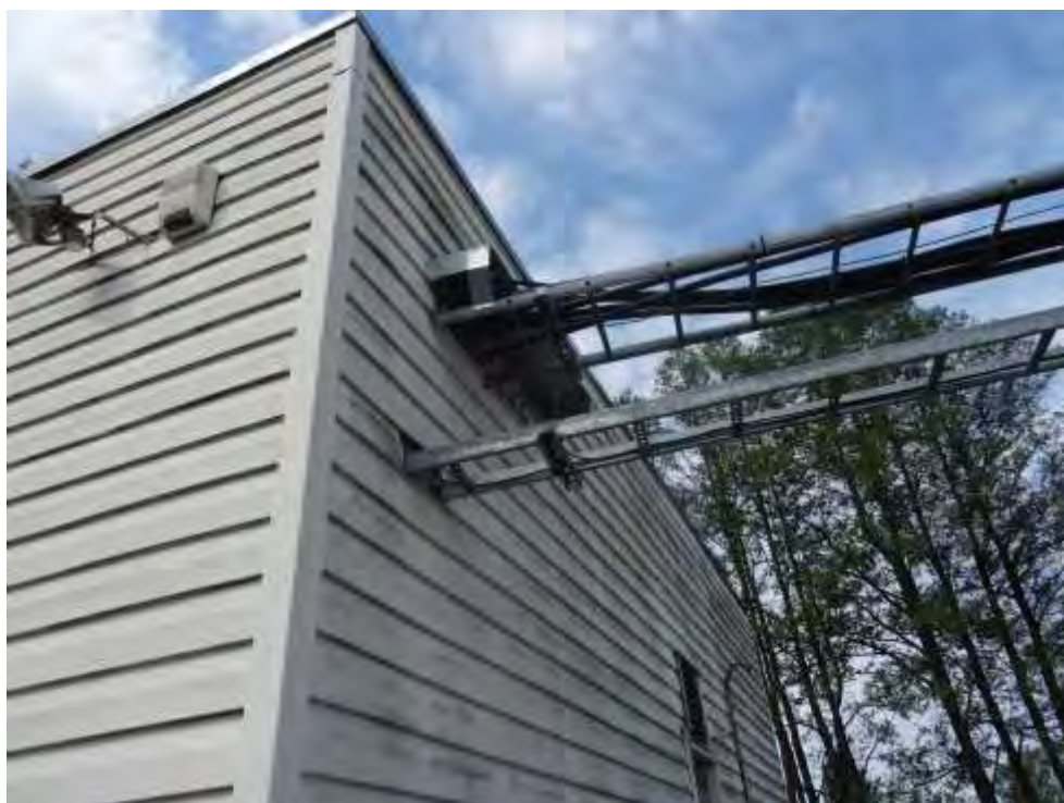
10.skatu punkts ( ĀRSIENAS SAVIENOJUMA AR KABELĒTREPI ZIEMEĻAUSTRUMU PUSES FASĀDEI )
