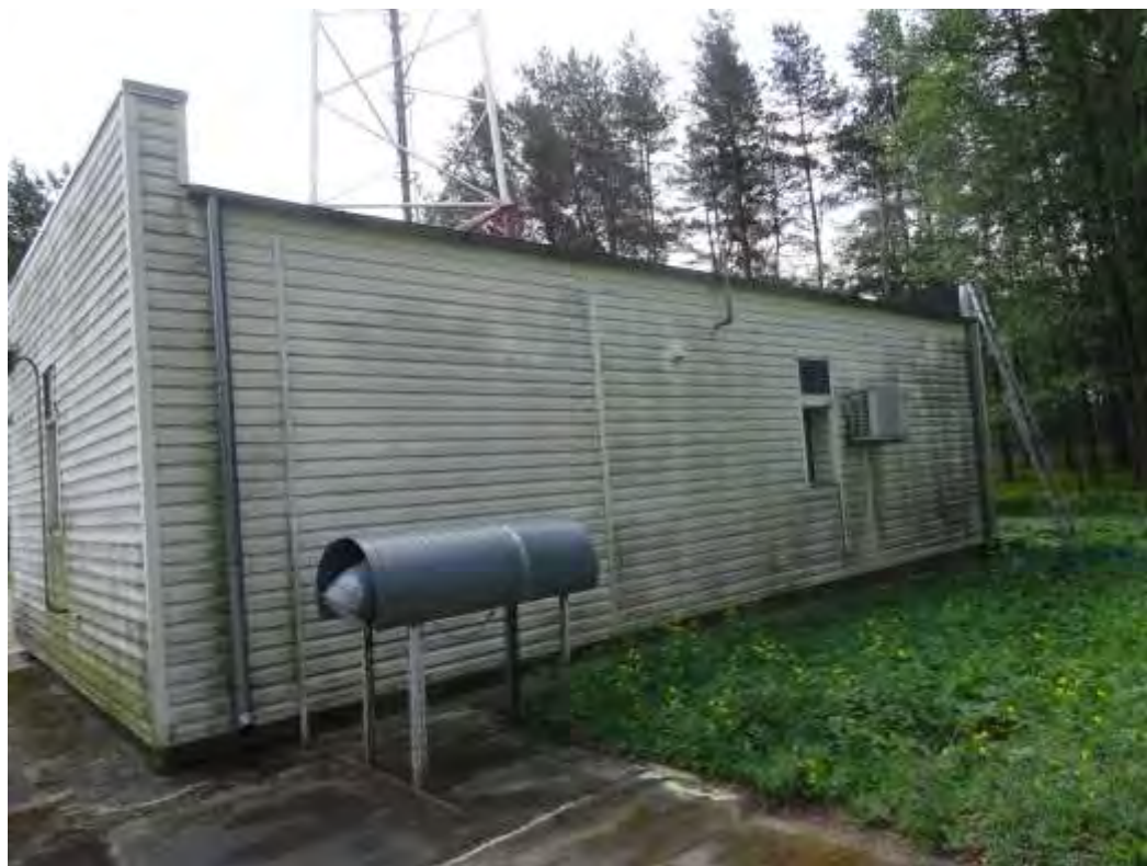
5.skatu punkts (ESOŠĀ FASĀDE RIETUMU PUSĒ)
