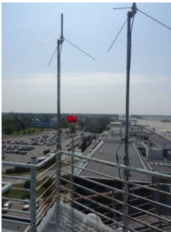
Attēls Nr.4 (Esošo antenu stiprinājumi, 1.platforma)
