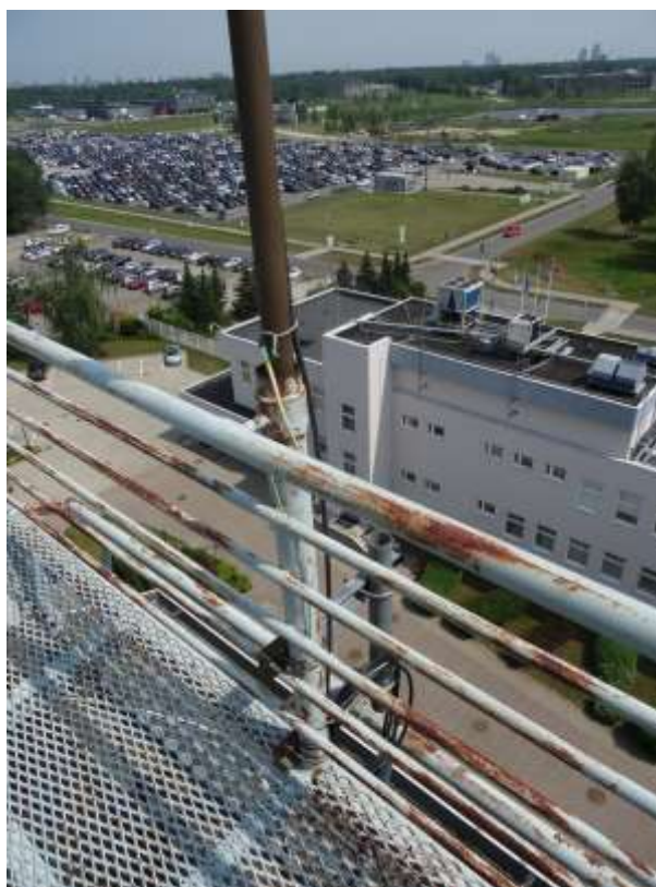
Attēls Nr.6 (Esošo antenu stiprinājumi, 2.platforma)
